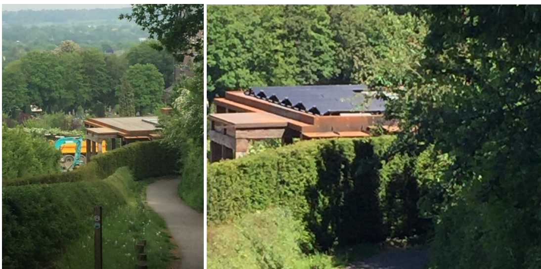
Voortgang van de bouwwerkzaamheden tussen 8 en 14 mei 2020.
